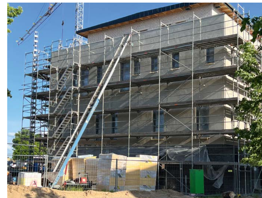
Auch am Neubau der Augenklinik waren die Gerüstbauer von SCHWAN beteiligt.
