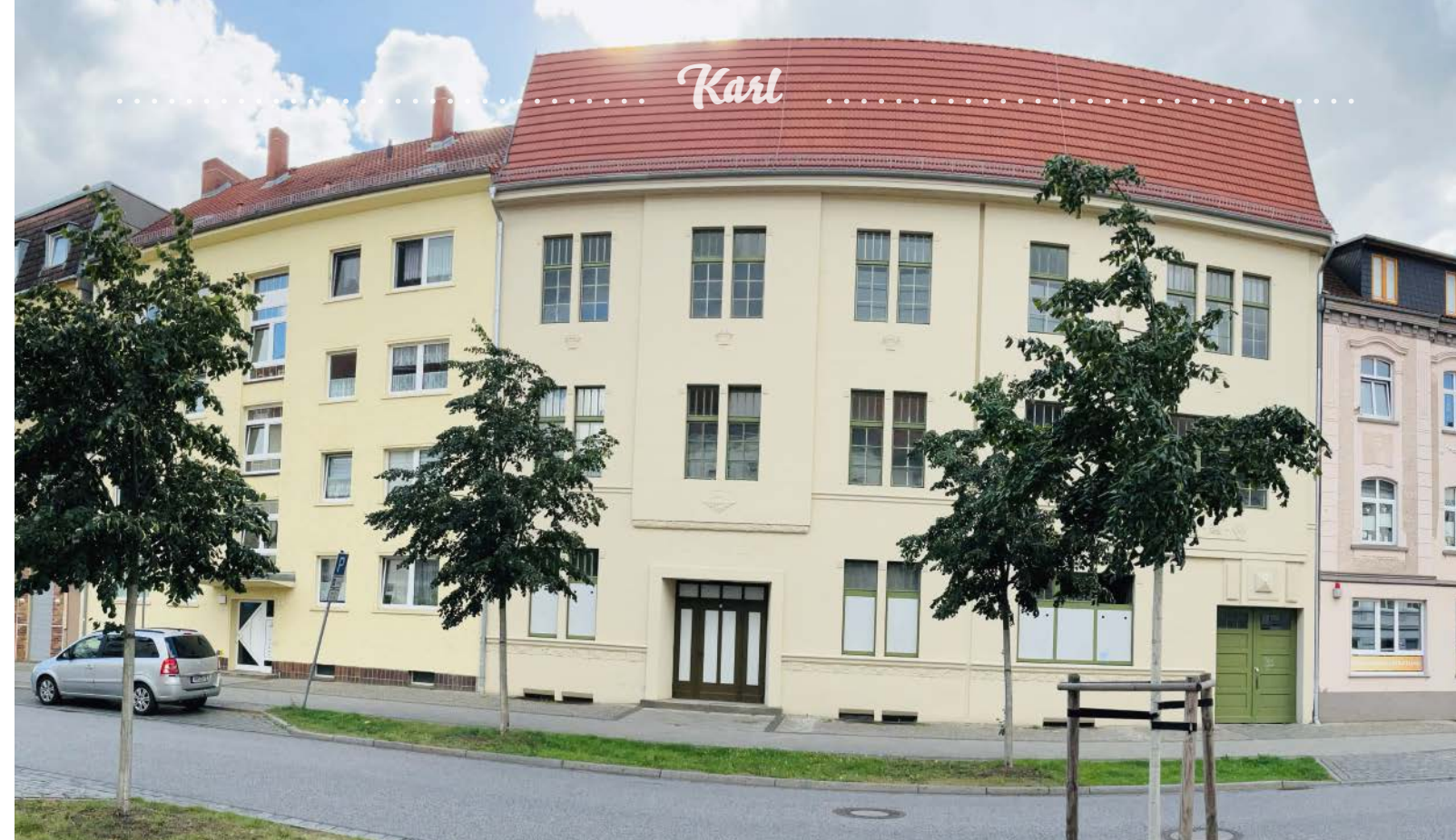
Die Wohnungsbaugesellschaft hat als 100-prozentige Tochter der Stadt in der Rathausstraße 40/42 das seit der Wende leerstehende ehemalige FDGB-Haus gekauft und mit großem Aufwand zu einem Ärztehaus umgebaut.
